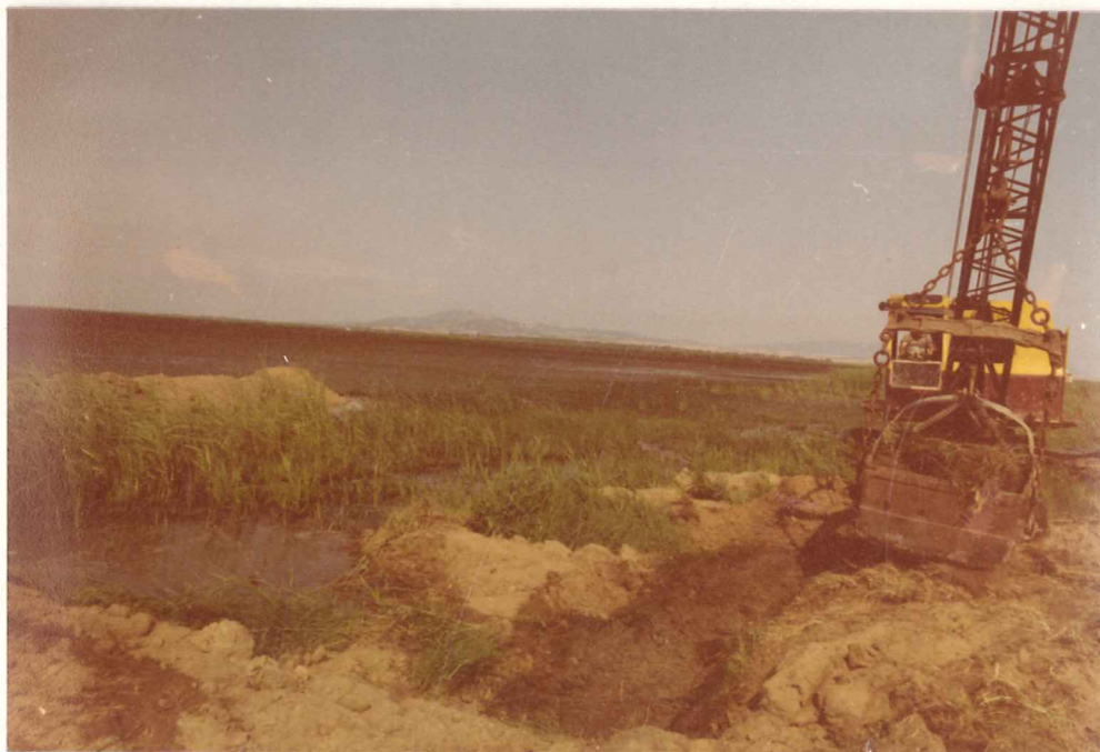
Εικ 4. Κατασκευή δεξαμενής στη λίμνη Μητρικού.
