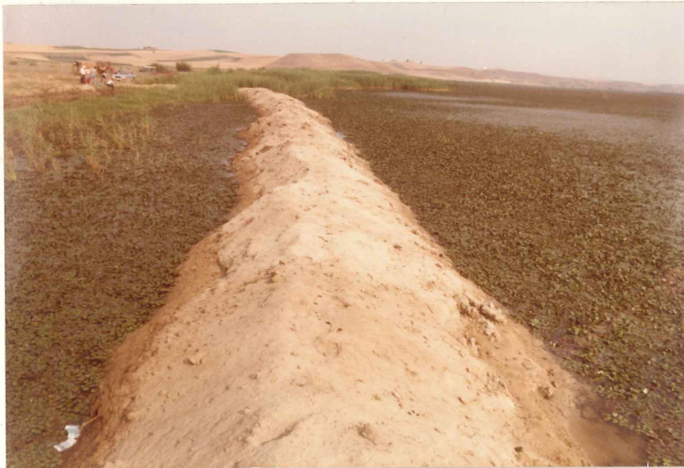
Εικ. 5. Δεξαμενή που κατασκευάστηκε στη λίμνη Μητρικού για την εγκατάσταση του πειραματισμού.
