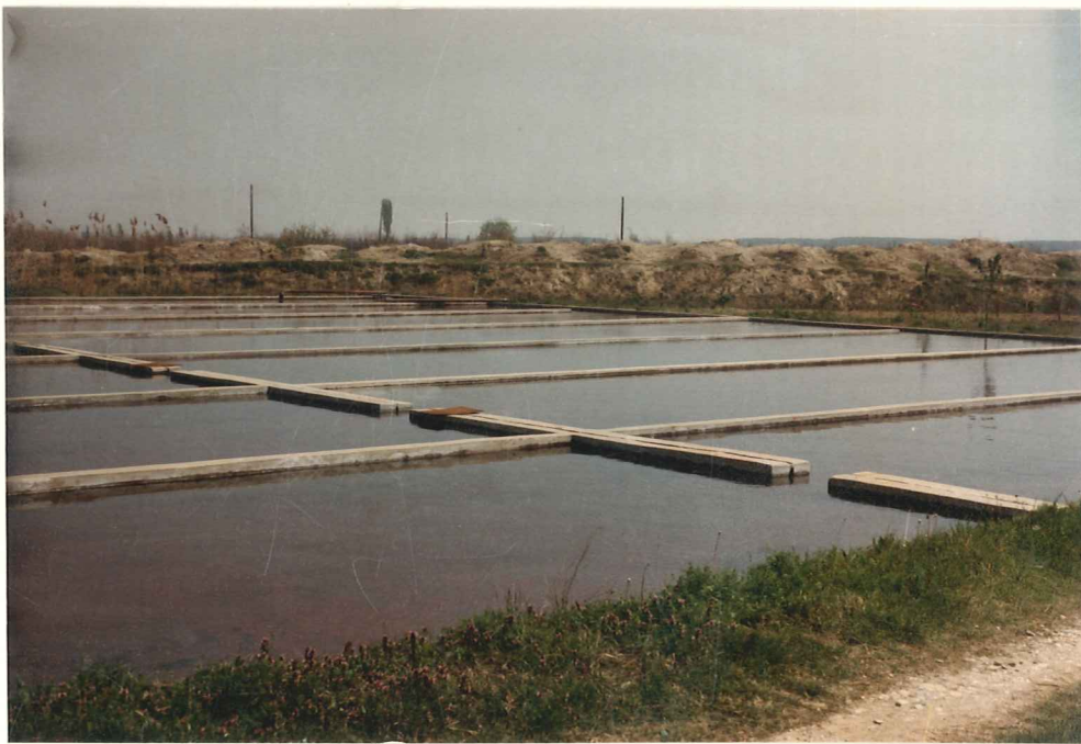
Εικ. 4. Λεκάνες προθερμάνσεως του αρτεσιανού νερού.
