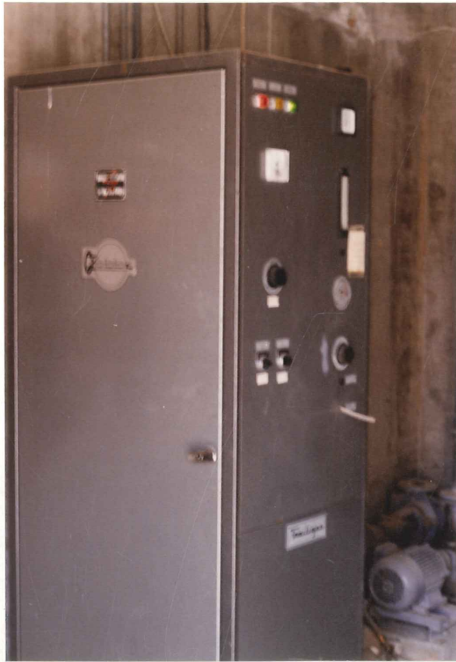
Εικ. 3. Οζονιστήρας για την παραγωγή όζοντος.
