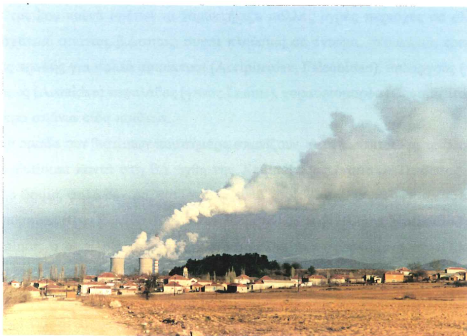
Εικ. 11. Ατμοηλεκτρικός σταθμός Δ.Ε.Η. (Α.Υ.Σ. Φιλώτα) βορειοανατολικά της λίμνης Χειμαδίτιδας. (Φωτ. Εργ. Οικολ. και Προστ. Περιβ., 1992)
