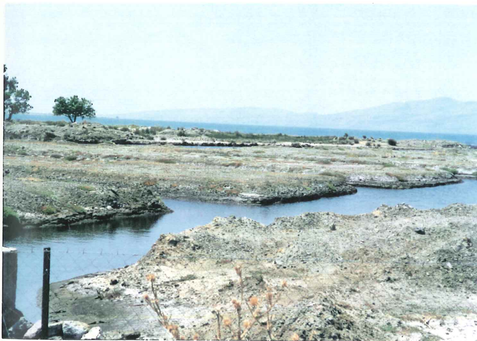
Εικ.22. Εκβολές χειμάρρου Βούβαρη και εγκαταστάσεις ιχθυοτροφείου (φωτ. Εργ. Οικολ. Προστ. Περιβαλ. Καλοκαίρι 1992)
