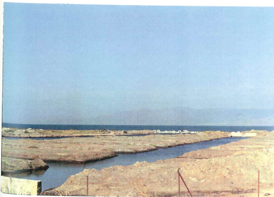
Εικ.23. Εσοδευτικό στόμιο για τις ανάγκες του ιχθυοτροφείου Βούβαρη (φωτ. Εργαστ. Οικολ. Προστ. Περιβαλ. Καλοκαίρι 1992)
