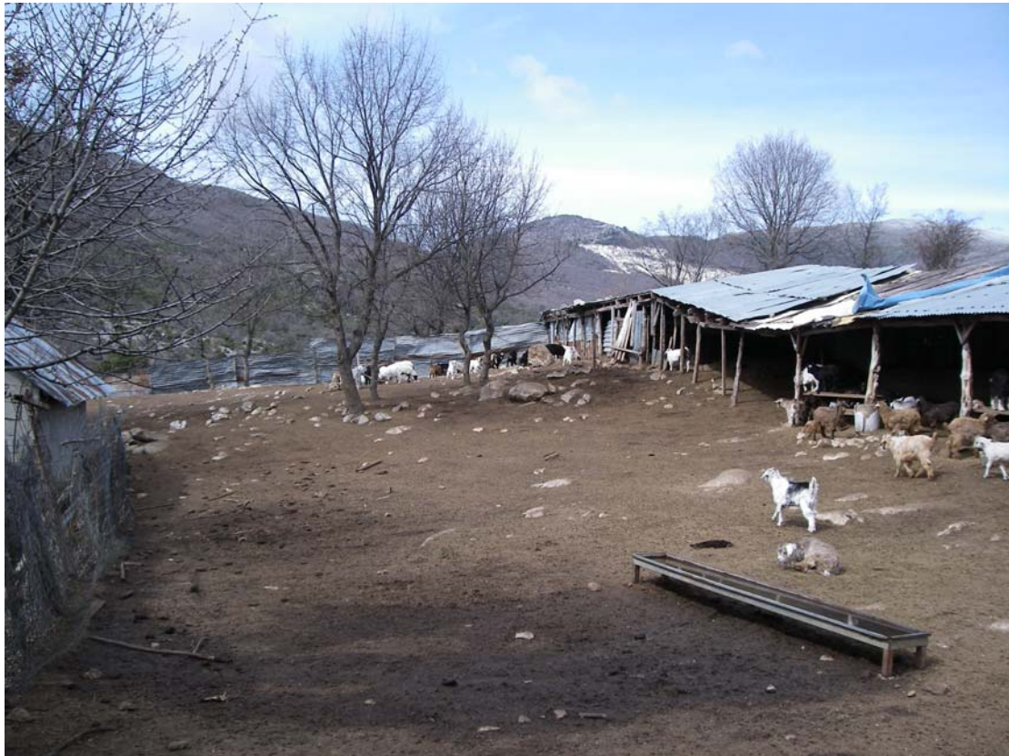
Εικόνα 8. Σταβλική εγκατάσταση ποιμνιοστασίου τύπου 1.
