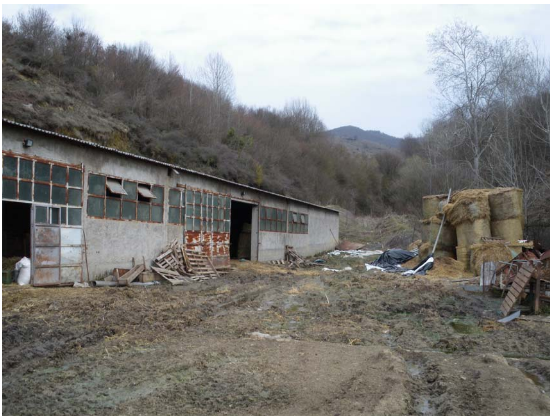
Εικόνα 9. Σταβλική εγκατάσταση ποιμνιοστασίου τύπου 2.
