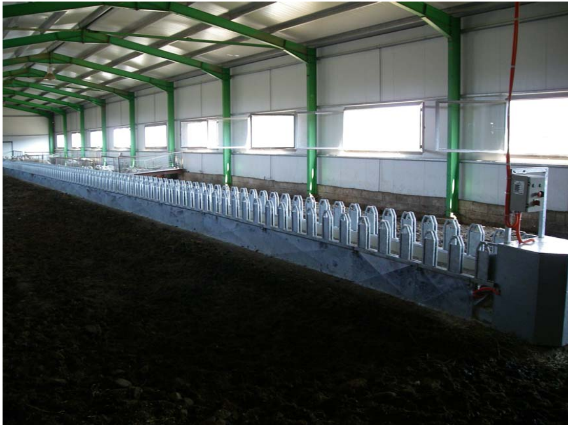
Εικόνα 10. Σταβλική εγκατάσταση ποιμνιοστασίου τύπου 3.
